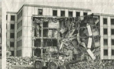
Vor 20 Jahren begann der Abriss der Investitions-Ruine, die noch zu DDR-Zeiten errichtet worden war: Die geplante Produktionsstätte des Textima-Kombinates für Mikroelektronik ging niemals in Betrieb.
