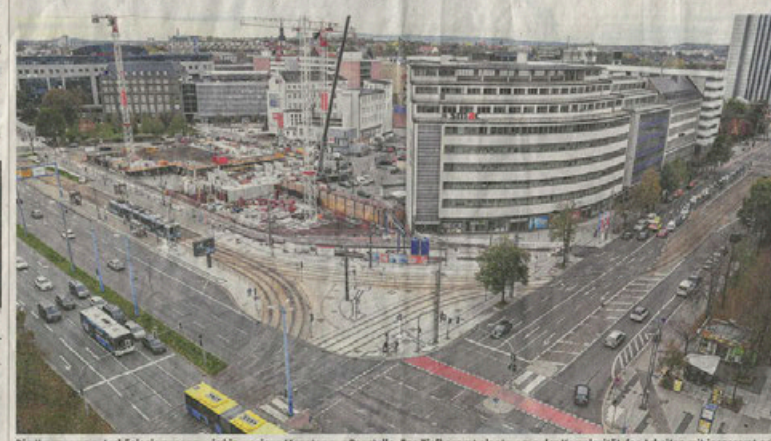
Die Kreuzung am Archäologiemuseum wird in wenigen Monaten zur Baustelle. Das Tiefbauamt plant wegen der Komplexität der Arbeiten mit insgesamt acht Bauphasen. Vollsperrungen soll es keine geben, wohl aber rechnet man mit massiven Verkehrsbehinderungen.
