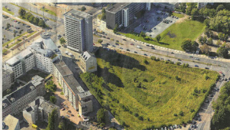
So viel Superlative sind selten: Das Contiloch ist die größte und älteste Baugrube von Chemnitz.
